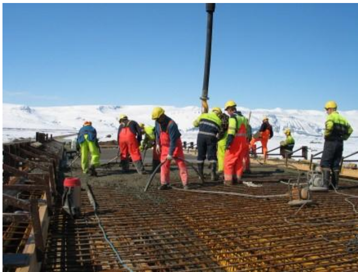
Byggingarvinna (heimild: www.nordurthing.is )
